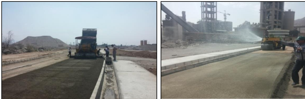
شکل ۶- ریختن و پخش کردن RCCP در جاده اختصاصی شرکت پرفیاب قبل و بعد از تراکم
