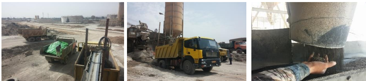
شکل ۵- مراحل انتقال بتن با نوار نقاله از بچینگ به کامیون و اقدامات لازم در حین بارگیری
