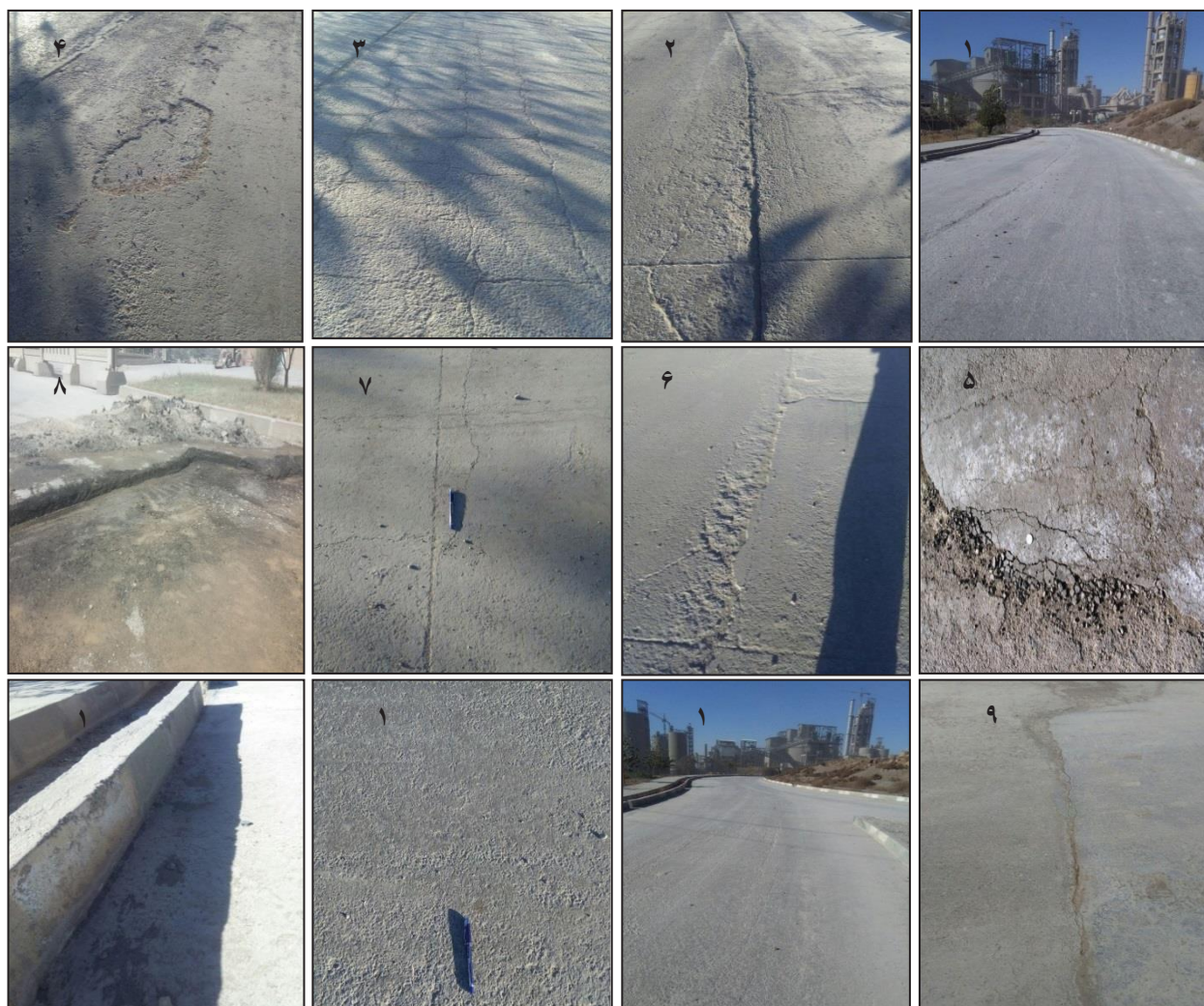
شکل ۱۰- سطوح مناسب و خرابی های ایجاد شده در رویه بتن غلتکی جاده اختصاصی پریفاب
