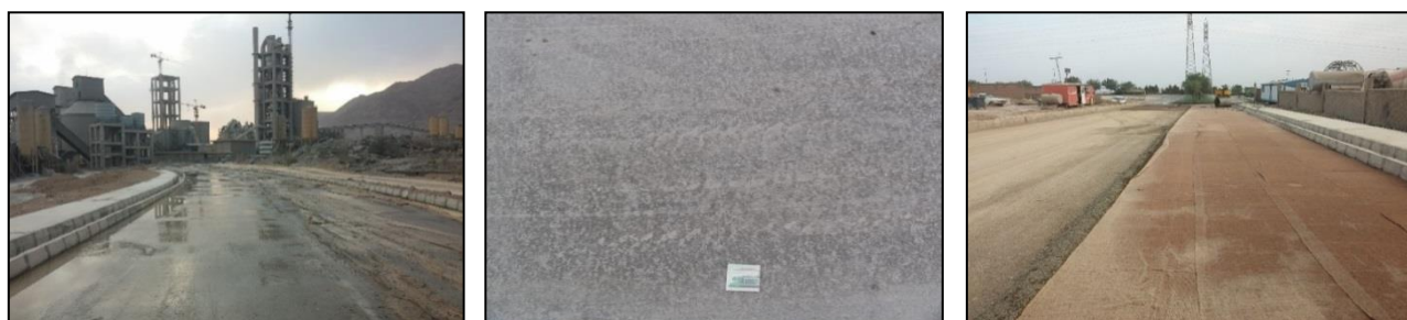
شکل ۸- اجرا و عمل‌آوری مناسب و ایجاد رویه بتنی سخت و متراکم
