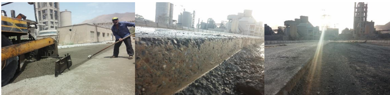
شکل ۷- مقطع طولی RCCP قبل شستشو (سمت راست) - مقطع RCCP پس از شستشو (وسط) - آماده‌سازی محل درز قبل تراکم (سمت چپ)
