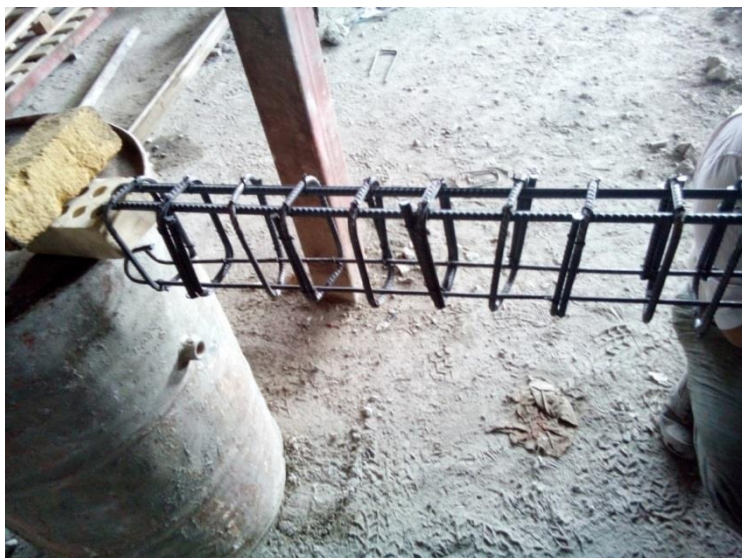
شکل ۲-۳) آرماتور بندی مقطع
