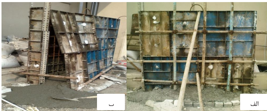
شکل ۴- الف) بلند شدن قالب از زمین به دلیل نیروی بلند شدگی ب) مهار قالب به زمین برای جلوگیری از بلند شدگی
