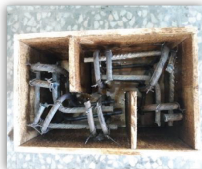
الف) آماده‌سازی قالب و میلگردها
