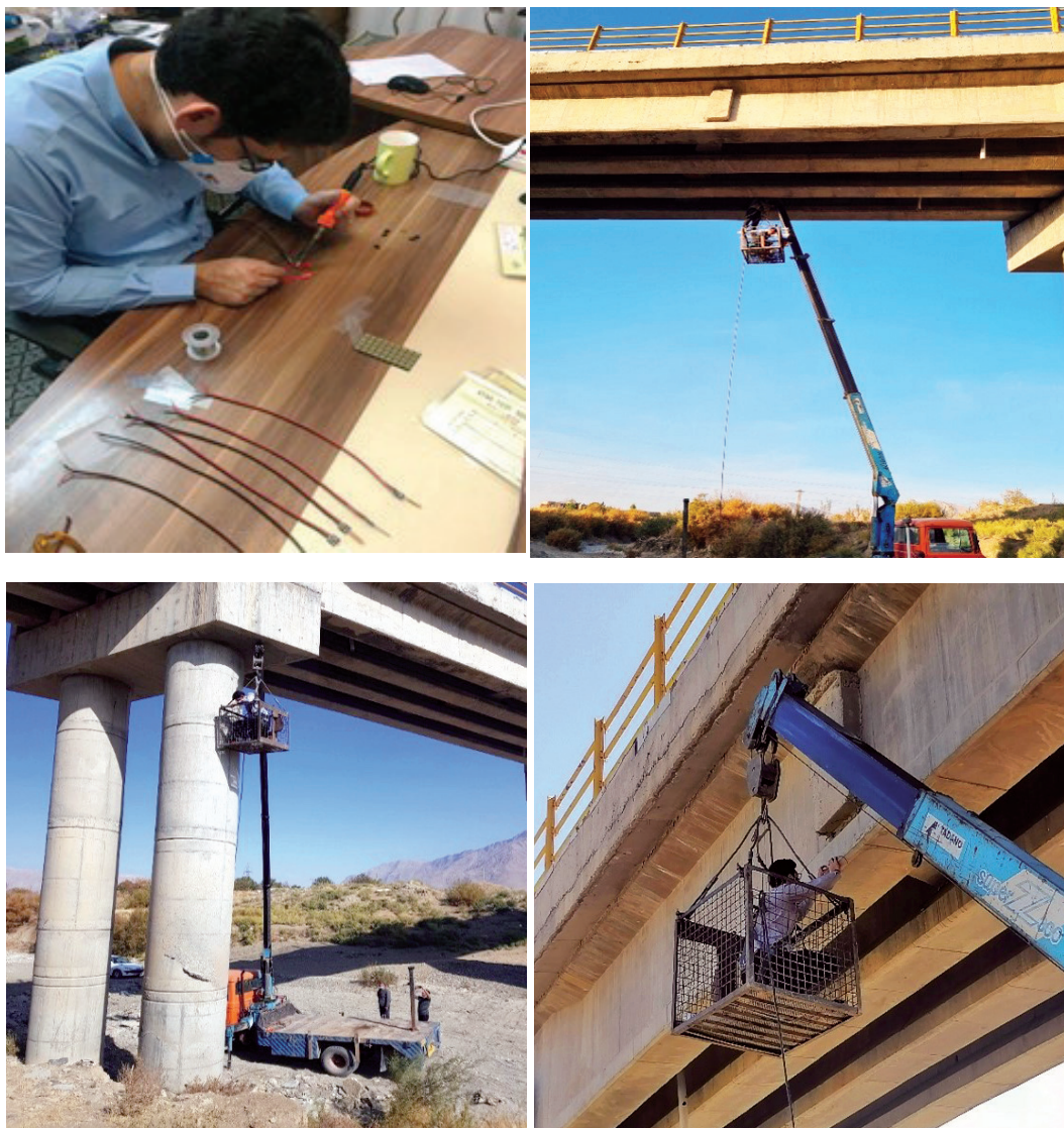
شکل ۵: آماده سازی و نصب کرنش سنج ها و ابزاربندی پل
