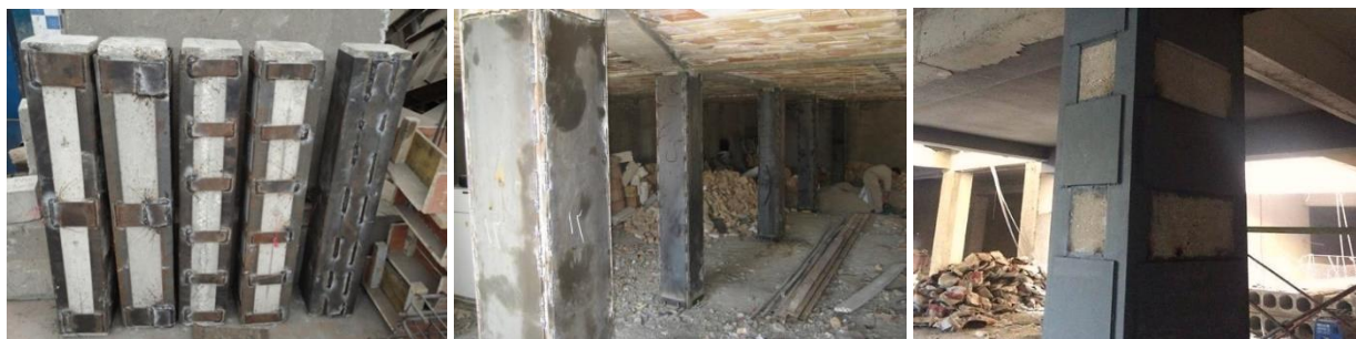
شکل ۲ انواع روش‌های مقاوم سازی ستون بتنی با ورق فولادی [۹،۸]
