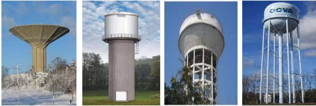
شکل ۱- برخی از نمونه‌های مخازن هوایی ذخیره مایعات با جنس مصالح، شکل هندسی محافظه و سازه نگهدارنده مختلف
