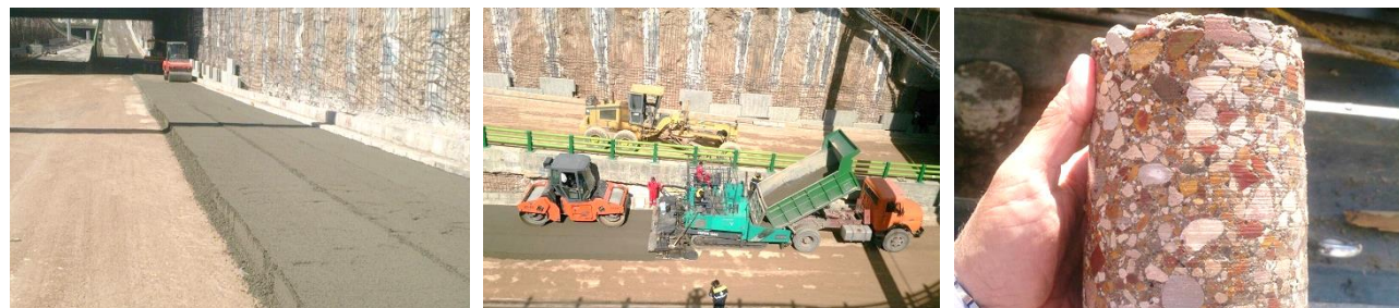
شکل ۱- راهسازی با بتن غلتکی پروژه راهسازی تقاطع غیرهمسطح دلگشا شیراز-۱۳۹۶ [۶,۵]
