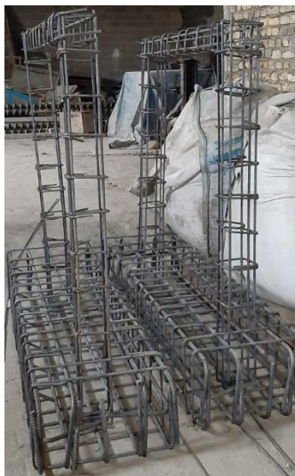
شکل ۴: آرماتور بندی قاب بتن آرمه.
