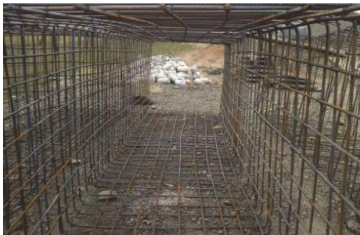
شکل ۲: آرماتوربندی سازه بتنی در مدل آزمایشگاهی
