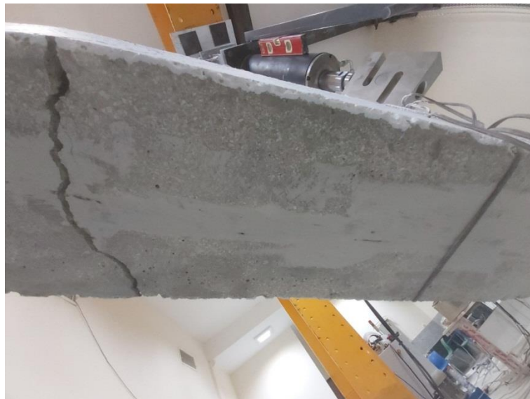
شکل ۱۳ مکانیسم شکست در تیر بتن مسلح تقویت شده با میلگرد GFRP
