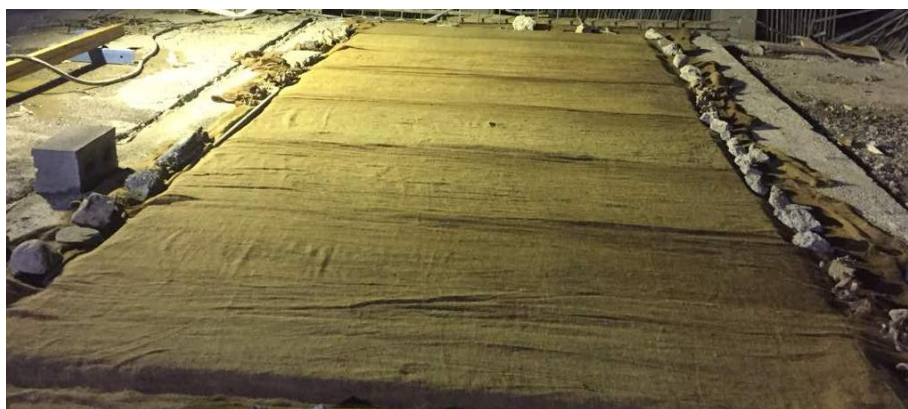
شکل ۱۹. عملیات پرداخت در پروژه
