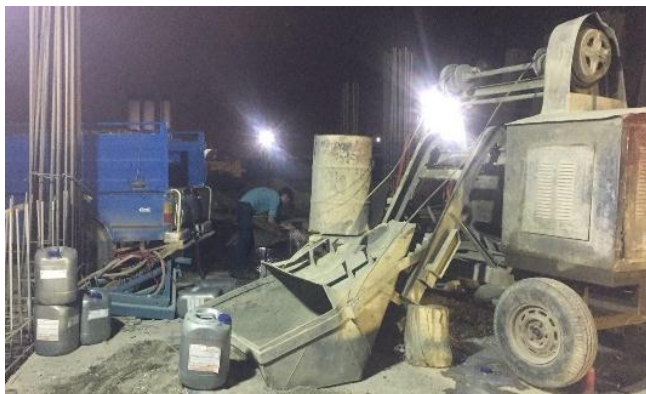
شکل ۱۲. خلاطه استفاده شده در پروژه
