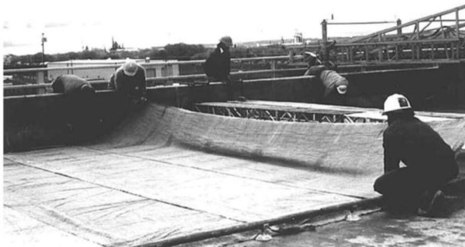
شکل ۱۸. عملیات پرداخت بتن لاتکسی
