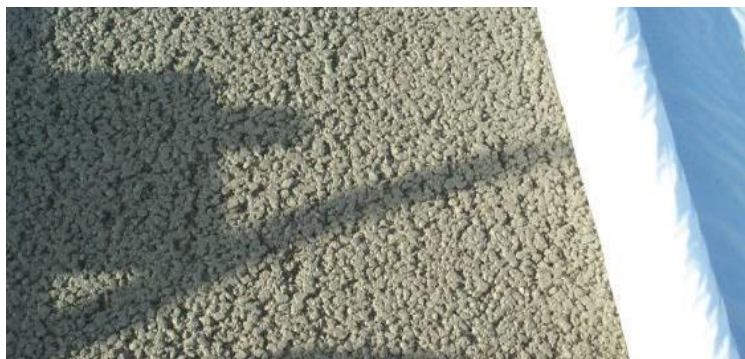
استفاده از بتن متخلخل
