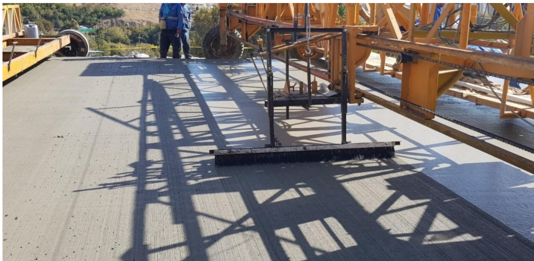
شکل ۱۱- دستگاه TCM فینیشر GP4000
